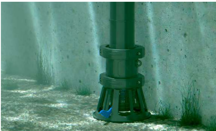
Detalle de instalación válvula de aspiración sistema de pie y sistema flotante. / Detail of installation of aspiration valve, foot and floating system.
